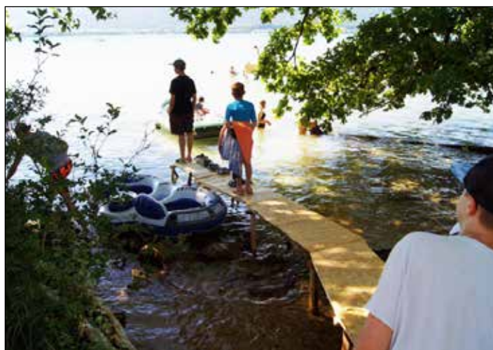
Diesen Anlegesteg haben die Pfadis selber gezimmert
